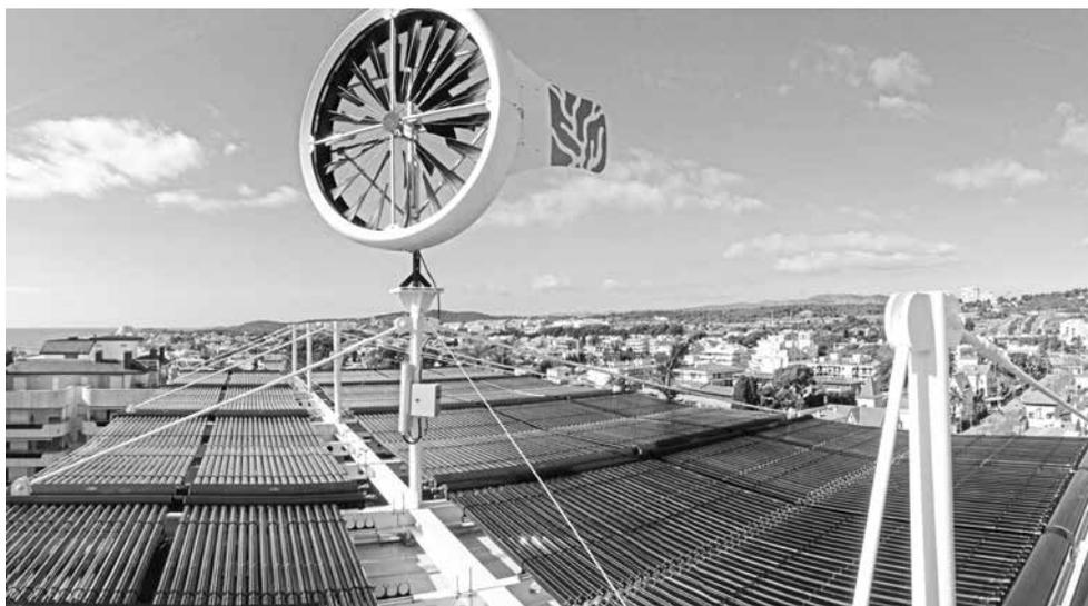
Cubierta con aerogenerador eólico, y calentadores de agua solares. *Hotel Boutique & Spa.*, en Sitges, España
