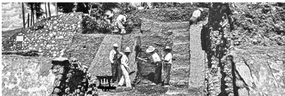
Trabajos en la fachada y escalera del montículo I. Fotograma del noticiario fílmico Actualidades Guatemaltecas de marzo de 1937. Digitalización: EB, 2014
