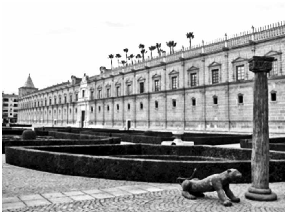
1. Fachada del Hospital de las Cinco Llagas de Sevilla. Fotografía LGS, febrero de 2014
