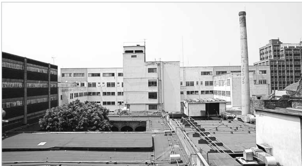
Fachadas interiores de las ampliaciones. Construcciones con diversidad de alturas, ritmos, proporciones de los vanos y de los acabados. En la remodelación de 1945, se dejó expuesta la estructura, se revistieron las fachadas con tezontle con la junta de concreto para enfatizar la composición horizontal. En la última ampliación la estructura quedó oculta con aplanados y pintura. Fotografía: MLGS, octubre de 2009
