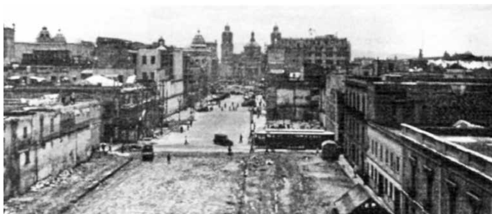
Obras de demolición para abrir la Av. 20 de Noviembre. Reprografía: MALS, octubre de 2007
