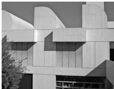
Vista de los lucernarios y paramentos de concreto armado – in situ y prefabricados– después de haber sido intervenidos. Como acabado final, se limpió totalmente la superficie de concreto y se aplicó una pintura que impidiera el paso de agua, pero permitiera la salida de vapor de agua. Foto: MEC, febrero de 2008.
