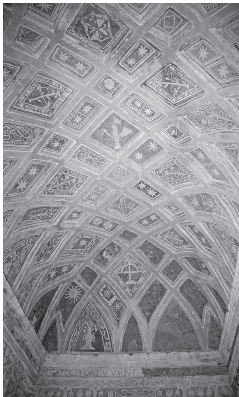
Chapultenango. Bóveda de la sacristía con nervaduras en diagonal y pintura mural en los tableros. Foto: Juan B. Artigas, 2010
