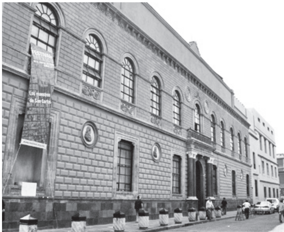
Fachada de la antigua Academia de San Carlos , realizada por Javier Cavallari a mediados del siglo XIX sobre el casco de un antiguo hospital novohispano.
