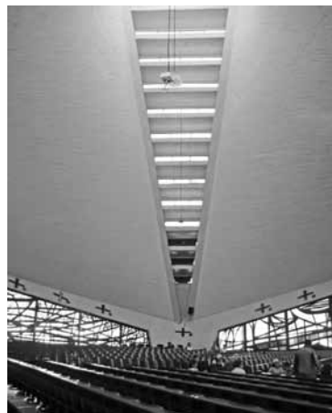
Vista interior, unión de paraboloides e iluminación cenital. Fotografía: JVR
