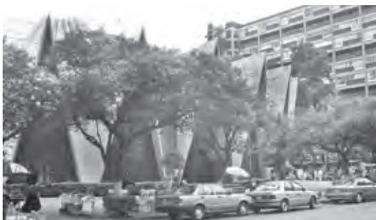
que alrededor, sus vértices se apoyan directamente sobre el piso. De este modo se eliminan los tradicionales muros de carga y se conforma así su característica fachada zigzagueante, que la destaca morfológicamente del entorno habitacional circundante. Tal criterio estructural fue sin duda más complejo de lo que se percibe, como mejor lo explica el especialista en estructuras Solís Ávila:
